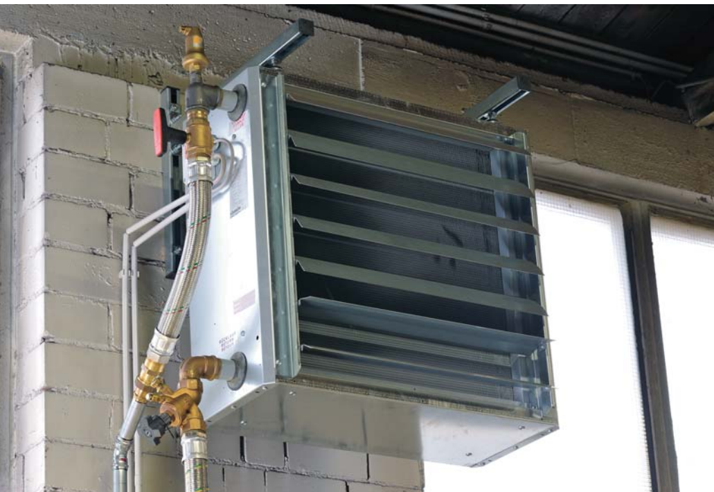
TIP Luftherzter mit bauseitiger Wandbefestigung TIP unit heaters with the customer's own wall fixings
